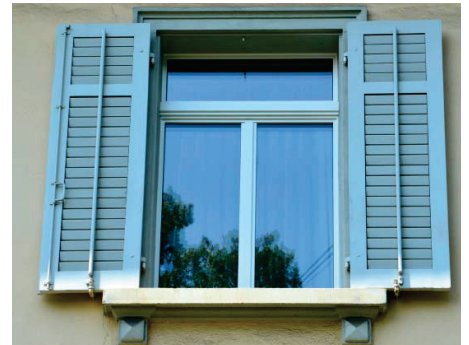
Sauberer Einbau mit dem Vollrahmenersatz.
