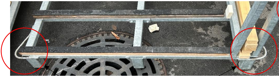
Durchschlaufen bei Anschlagen am Kran
