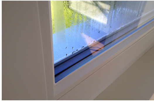
Trotz hochwärmedämmender Isoliergläser können moderne Fenster auch Kondensatbildung aufweisen, insbesondere im Falzraum. Kondensat auf der Aussenseite von Isoliergläsern (Abb. links) ist hingegen ein Qualitätsmerkmal der guten Wärmedämmeigenschaften.
