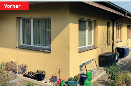
Das Haus vor der Sanierung.
